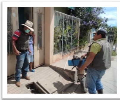
Reposición e instalación de caja y medidores de agua a servicios antiguos en el Casco Urbano
