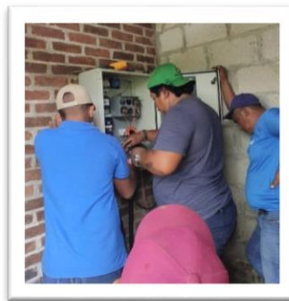
Cambio de bomba y transformador eléctrico en sistema de agua de la comunidad del Cerrón.
