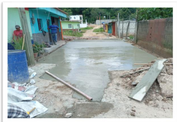
PAVIMENTO BARRIO EL PUENTE OLOPA
