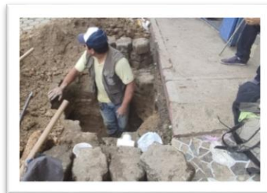
Instalación de nuevos servicios de agua.
